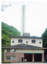
東温市クリーンセンター
